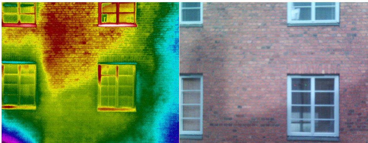
Kuvat 14. Massiivitiili julkisivun lämpökuva ja valokuva. Kohteessa ei havaittu vaurioita tai eristevikoja. Kuvassa näkyy auringon aiheuttamaa lämpöjälkeä.
