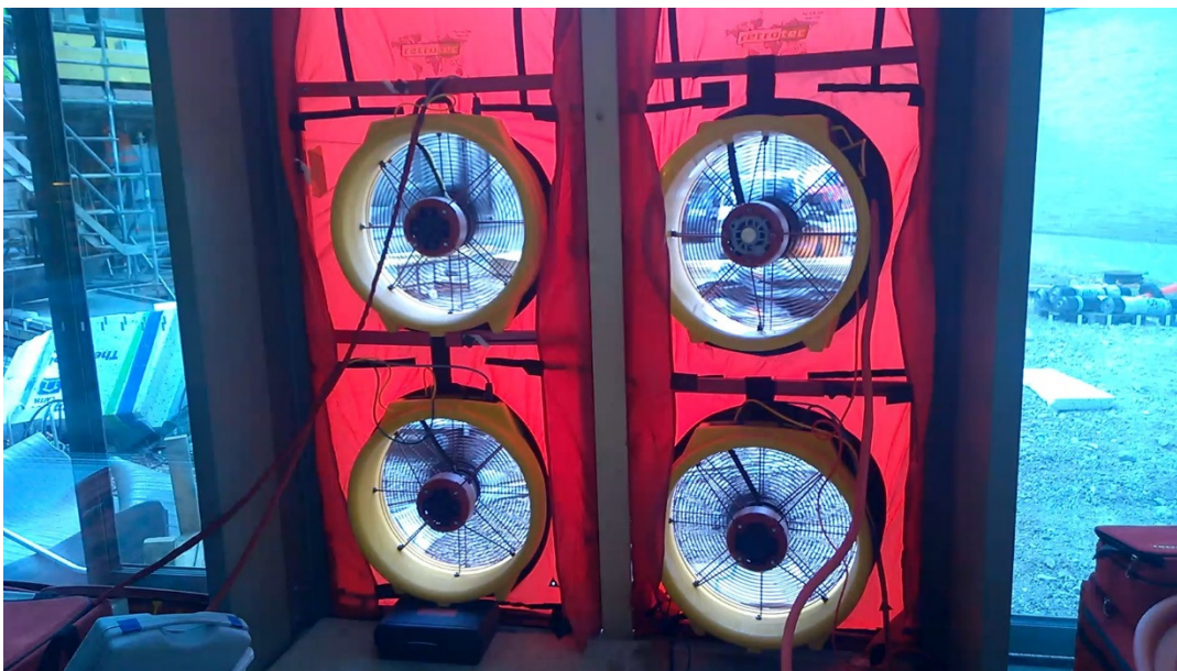
Kuvat 10. Tiiveysmittauslaitteistot työmaalle menossa ja oveen asennettuna, paineistus käynnissä. Rakennus on suuri jolloin tiiveysmittauslaitteita on 4kpl.
