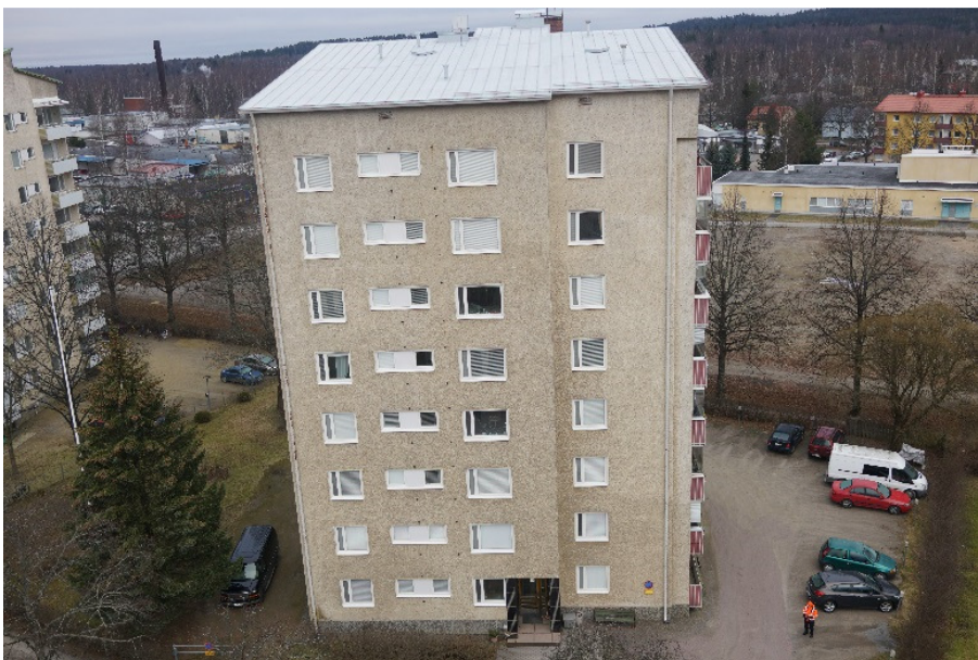
Kuva 3. VideoDronen erillisen digikameran ottama kuva vastaavasta julkisivusta kuin kuva 2.
